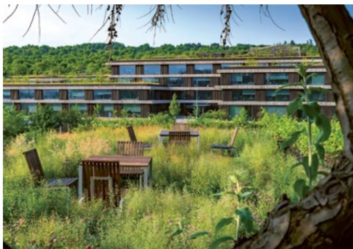
Pohled z budovy NHQ na budovu SHQ v Radlicích
